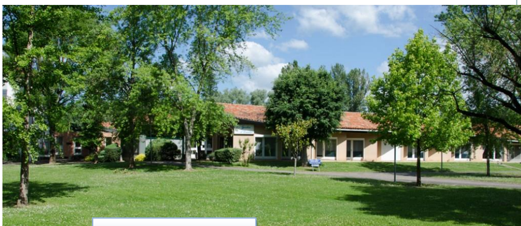
Site de Caussade
